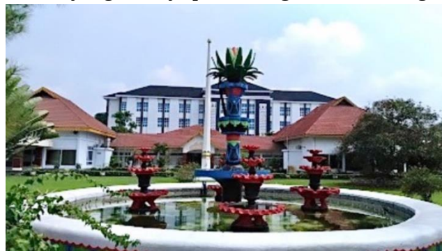
Gambar 1. Tampak bangunan Balai Kota Tebing Tinggi
