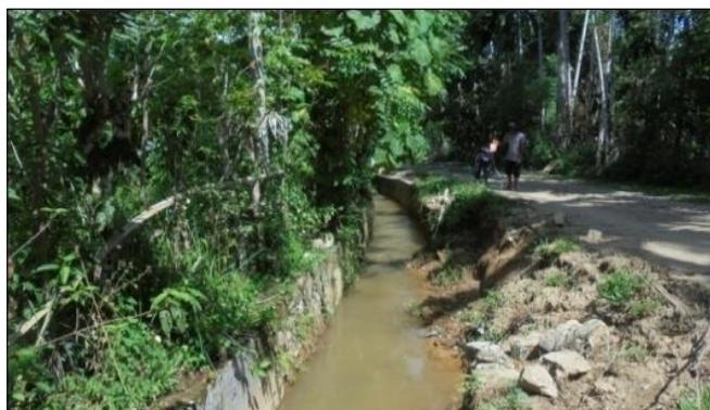
**Gambar 4. Kerusakan saluran sekunder sepanjang 33 meter. pada Ruas BMG. 3 - BMG. 4**
