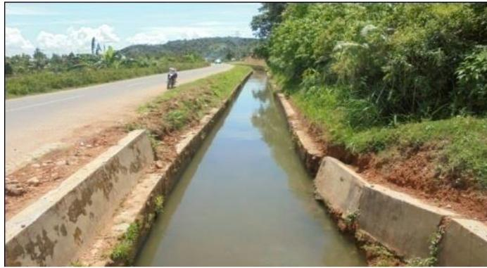
**Gambar 1. Kerusakan saluran sekunder sepanjang 26 meter pada ruas BKL.2 - BMG.1.**
