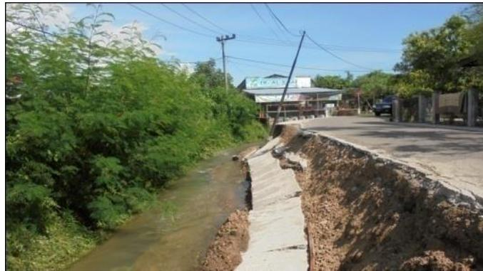
**Gambar 5. Kerusakan saluran sekunder sepanjang 200 meter, Pada ruas BSM.1 - BSM.2**
