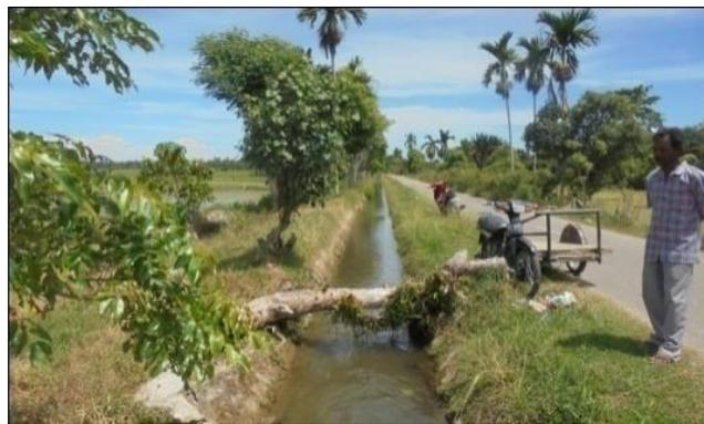
**Gambar 2. Kerusakan saluran sekunder sepanjang 42 meter pada ruas BKL.2 ruas BAL.4 - BAL.5.**
