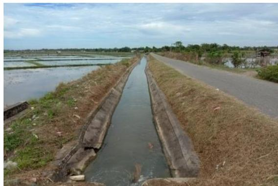
**Gambar 6. Kerusakan saluran sekunder sepanjang 82 meter, Pada Ruas BAL.1 - BAL.2**
