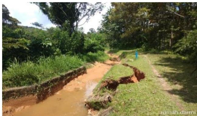
**Gambar 3. Kerusakan saluran sekunder sepanjang 165 meter. pada ruas BMG. 2 - BMG. 3.**
